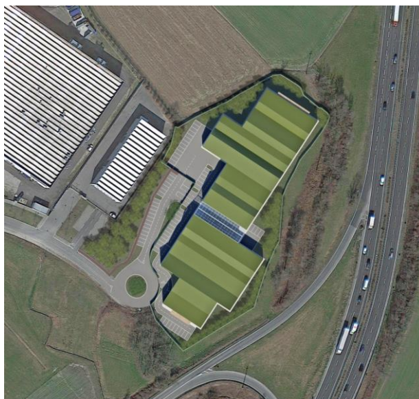
Inserimento edifici nel contesto: vista area coperture
